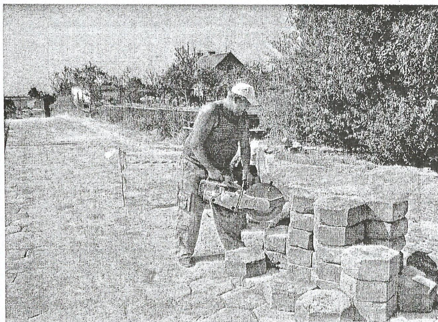
Trwa remont ul. Na Borku. Pan Edek z niebezpieczną maszyną, dobrze sobie radzi.
