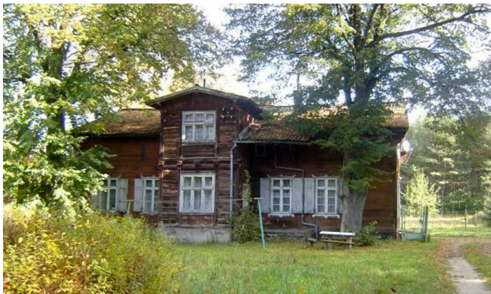
Budynek mieszkalny w Szladze – 2010 rok
