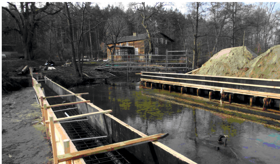
Budowa nowego mostu w Szladze – wiosna 2013 rok
